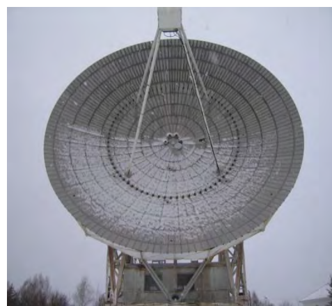
Рисунок 2. Наземная станция слежения на базе РТ – 22 (Пушино)
