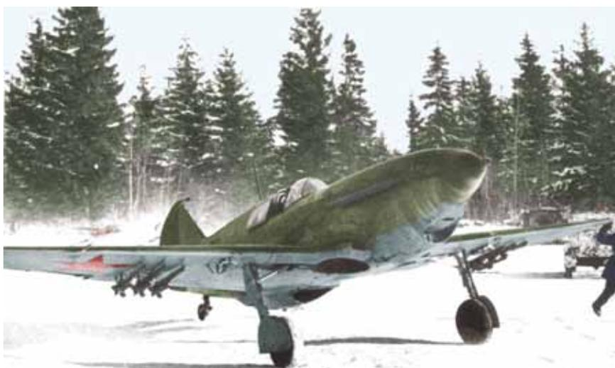
**рисунок 1.** Истребитель ЛаГГ-3 с реактивными снарядами РС-82 разработки НИИ-3
