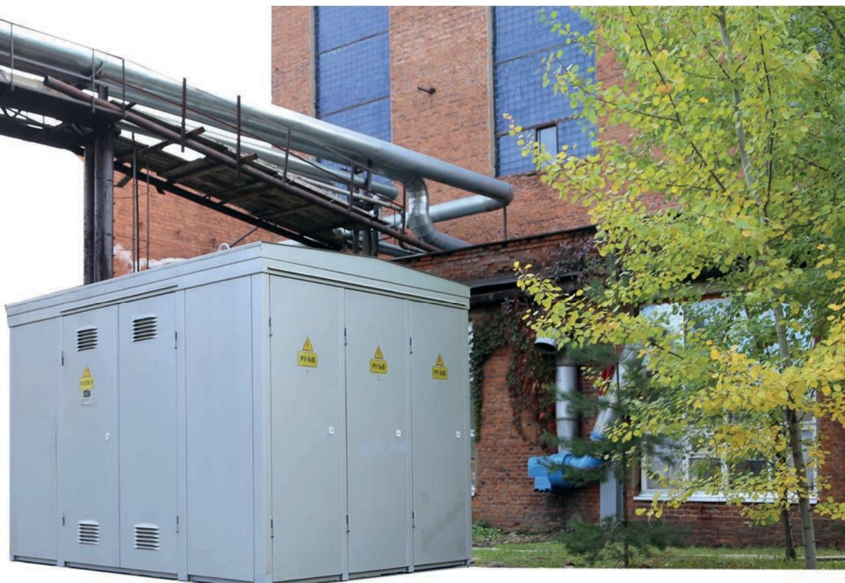
В самом ЦТП тоже было серьезное обновление – полностью реконструировали сборку электрощита: установили новые автоматические выключатели, протянули медные кабели. Сейчас надежность насосов стопроцентная – утверждают энергетики.
