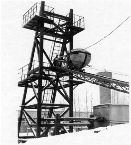
рисунок 4. Общий вид катапульты стенда сброса
