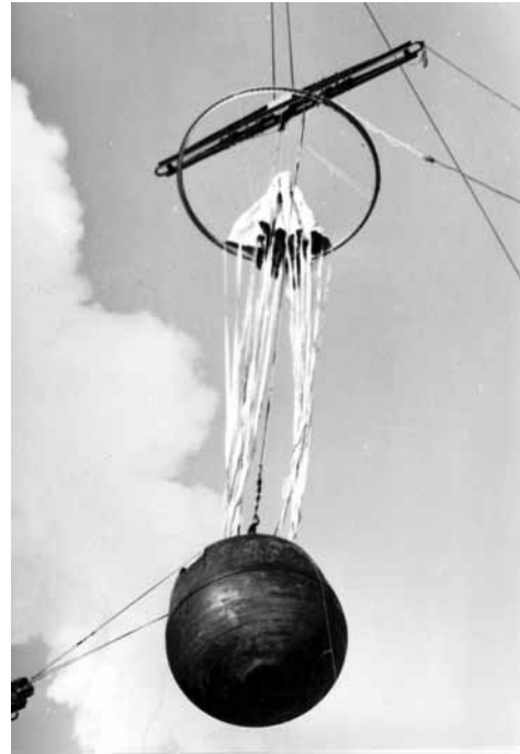
рисунок 9. Отработка парашютной системы АМС «Венера-4,...,-8»
