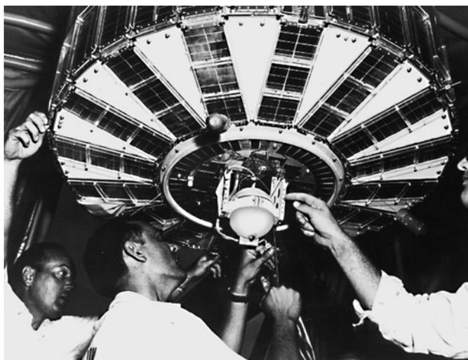
**рисунок 1.** Установка РИТЭГ SNAP-3B в спутник «TRANSIT 4a»
