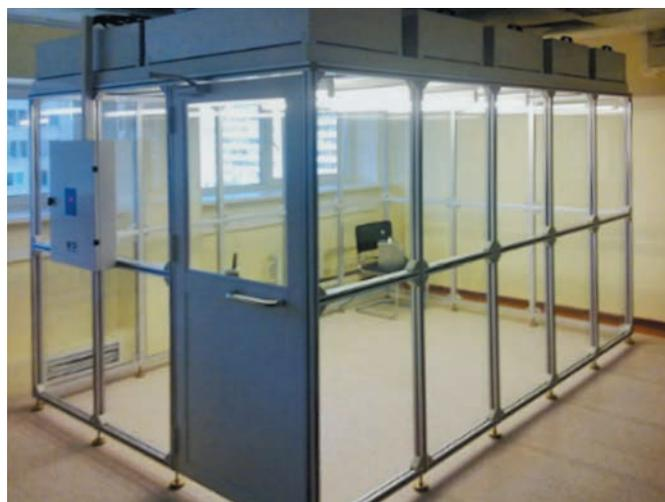
рисунок 7. Локальная чистая зона на основе внутрицевых каркасных конструкций
