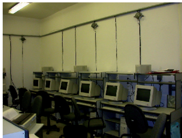
рисунок 4. Подсистема обработки информации. Помещение 8-13 сооружения 100 площадки 31 Байконура. 1999 год
