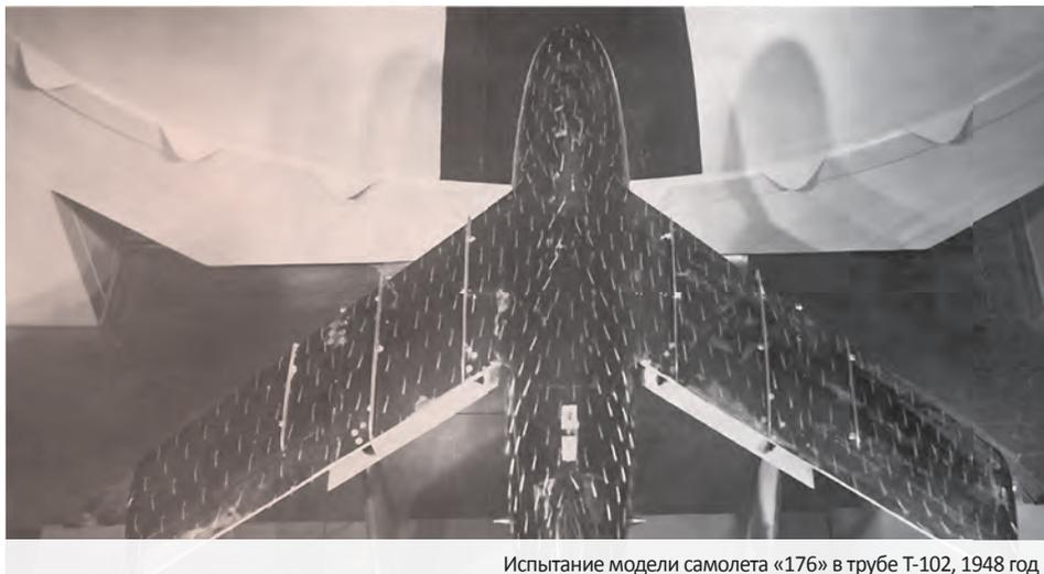
Испытание модели самолета «176» в трубе Т-102, 1948 год
